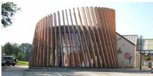
Construction d'une garderie à Mervans
